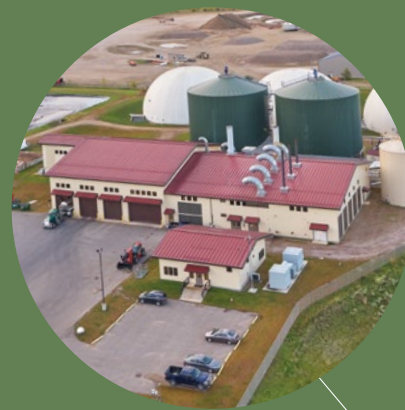
HOMETOWN BIOENERGY LE SUEUR, MN 8 MW, BioEnergy
