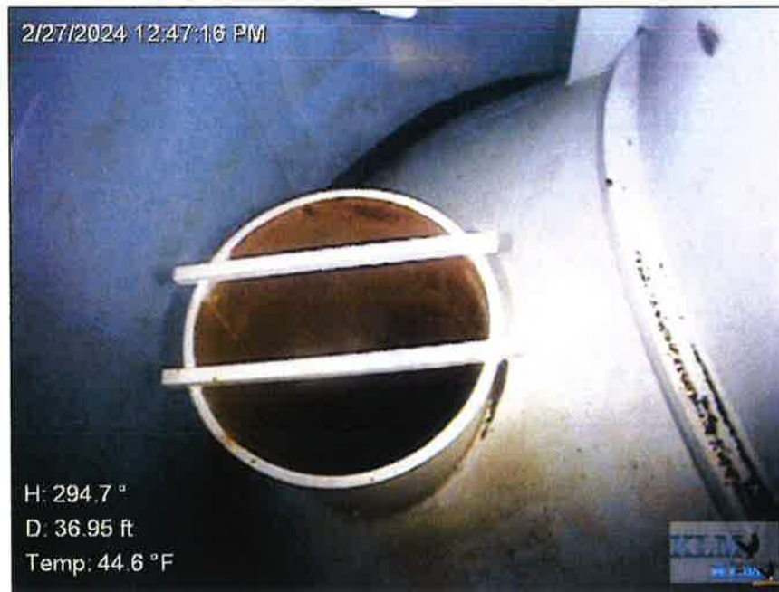
Photo No. 20 Fill pipe
