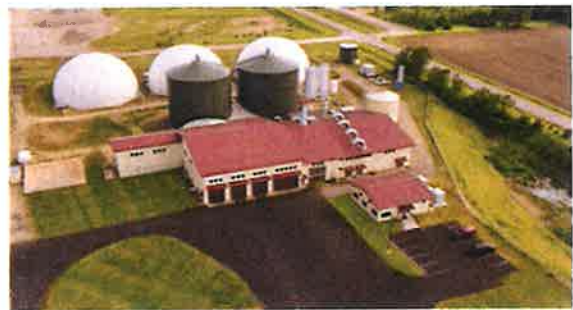
HOMETOWN BIOENERGY LE SUEUR, MN 8 MW, BIOENERGY
